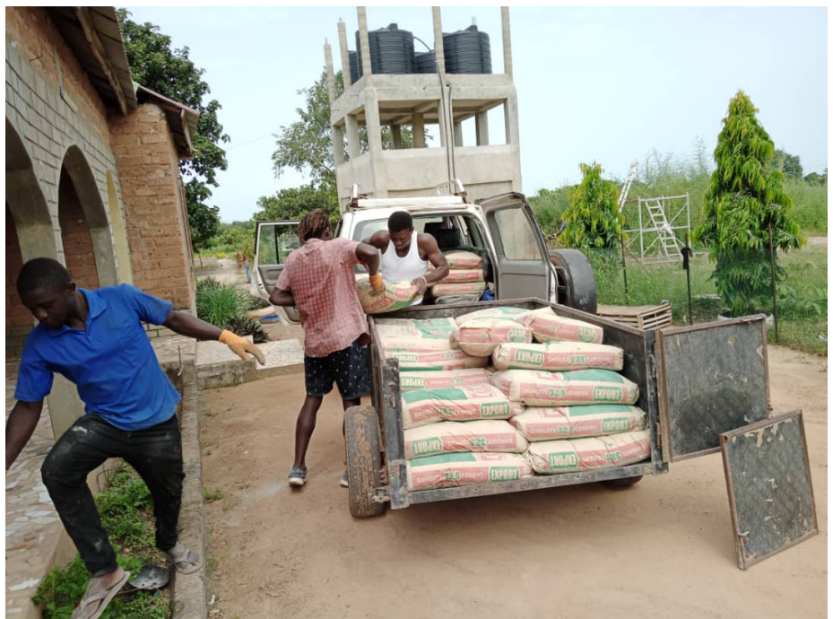
Zementeinkauf für einen weiteren Bauabschnitt auf dem IMWA Land
